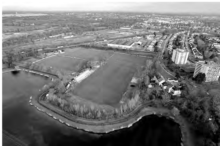
Münchfeldsee in Rastatt: Geplant ist, im Bereich der Fußballplätze das neue Klinikum Baden-Baden/Rastatt zu bauen./Foto: Landratsamt/Benjamin Wedewart
